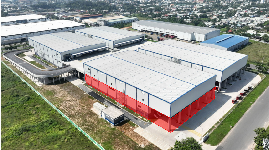
【倉庫外観（施設全体）※4】
