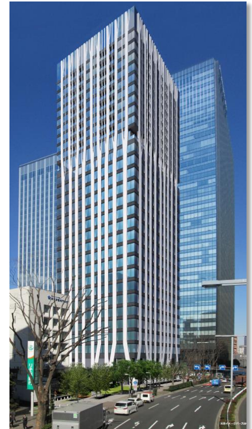
サービスアパートメントや オフィス等の複合施設 西新宿Dタワー（東京都）
