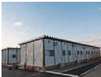
完成した仮設住宅
