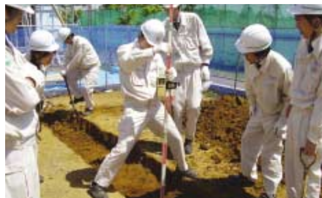
建築現場にて測量実習を行う新入社員
