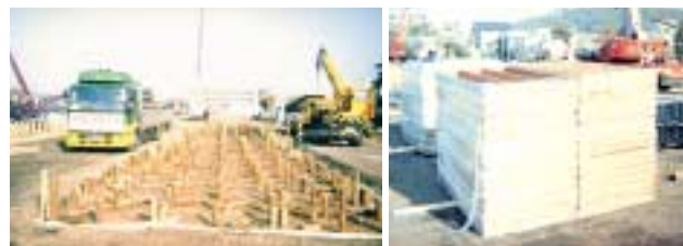
仮設住宅用の部材を運搬する救援物資輸送車
