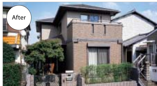
外壁やサッシに新築部材を採用した全面リフォーム
