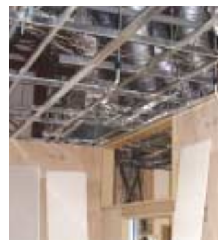
内装化粧板・下地合板のプレカット化
