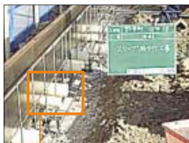
ABS樹脂製スリーブ型枠の施工風景 リユース可能なABS樹脂製スリーブ型枠
