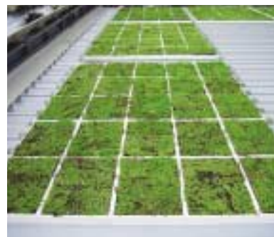
屋上緑化システム
