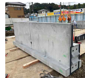
プレキャストコンクリート工法
